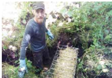
5. Filtre à paille à l'exutoire du chenal Gestion des mares 2018
