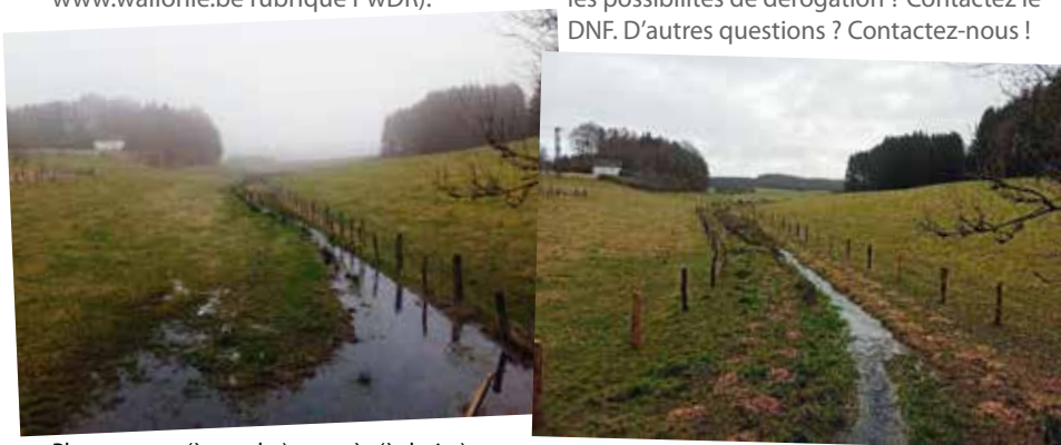
Photos avant (à gauche) et après (à droite) d'un projet de plantation d'un cordon rivulaire avec deux lignes de plantation (en «double rang»), et pose de clôtures de part et d'autre du cours d'eau.
